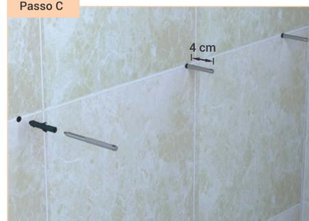
Insira a **bucha** (item 1) do seu kit de instalação que acompanha o produto e **em seguida** insira o **parafuso** (item 2) **deixando 4 cm** para fora da parede para a fixação do lavatório.
