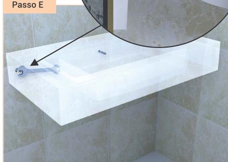
Encaixe o **lavatório** nos **parafusos** fixos na parede e insira a **arruela plástica** (item 3), **arruela lisa** (item 4) e a **porca para parafuso** (item 5) do seu kit, conforme foto de detalhe. **Aperte** a porca (item 5) com uma chave de boca 13 mm e deixe uma leve folga.
